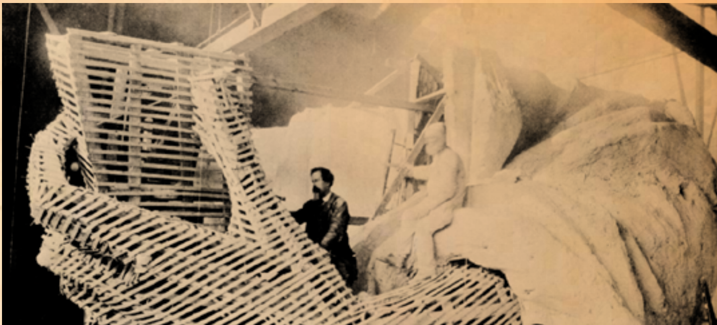
„Face Lifting”, czyli wciąganie i montaż elementów twarzy Miss Liberty. Widok od wewnątrz. (archiwum)
