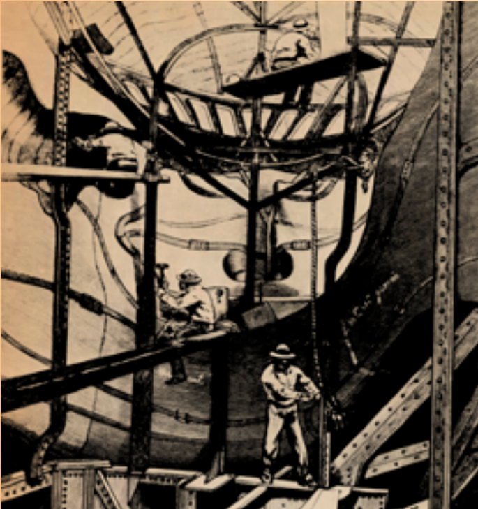
Na takich szablona formowano blachę miedzianą tworzącą zewnętrzną powłokę monumentu. (archiwum)
